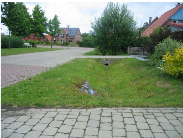
Abbildung 42: Beispiel Entwässerungsmulde mit Überfahrt Quelle: eigene Aufnahme
