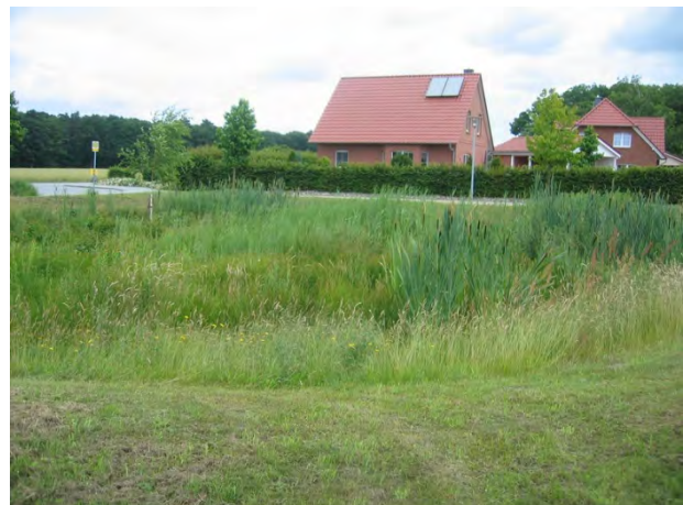
Abbildung 43: Beispiel Regenwasserrückhaltung als Kleinbiotop Quelle: eigene Aufnahme
