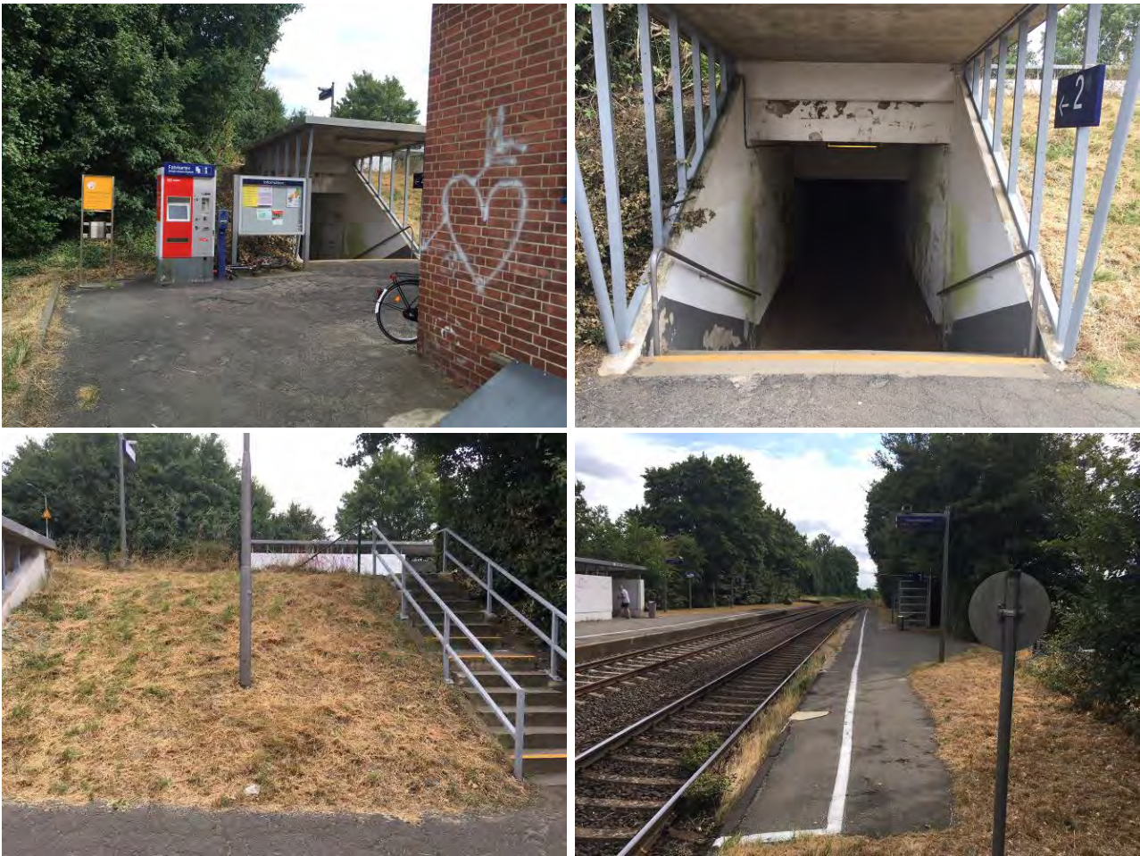
Abbildung 21: Bahnhof Salzgitter-Thiede Quelle: eigene Aufnahmen, Sept. 2018
